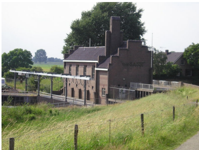
Estación de bombeo elevando el agua de drenaje
