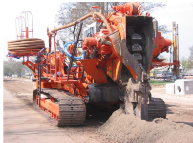
Máquina drenadora enterrando tubería plástica
