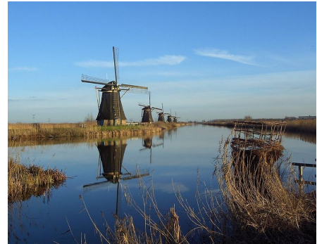
Molinos antiguos evacuando el agua de drenaje de los pólderes interiores al río entre diques
